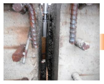
UP・DOWN型ロボットUDL369による橋梁遊間端部のはつり状況。従来工法ではこのような狭い空間でのはつり作業は不可能です。
