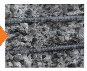
はつり完了後は鉄筋周囲のコンクリート脆弱部が除去され、非常に良好な施工面を得ることができます。
