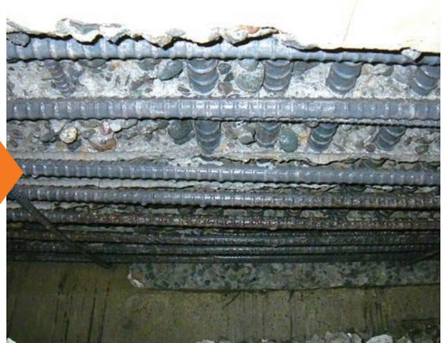
はつり完了後は鉄筋周囲のコンクリート脆弱部が除去され、非常に良好な施工面を得ることができます。
