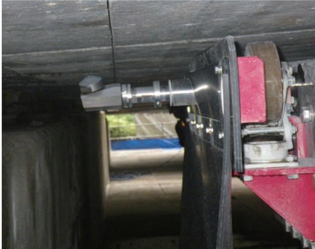
アップジェット1000による橋梁床版下面のはつり状況。従来工法ではこのような狭い空間でののはつり作業は不可能です。
