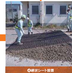
④網状シート設置
